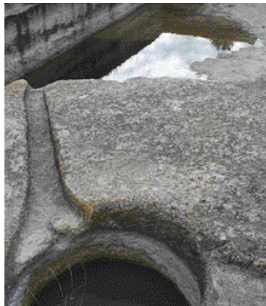
Balsa para riego excavada en roca. Balsa de las Bodeguillas (BBode-02).
