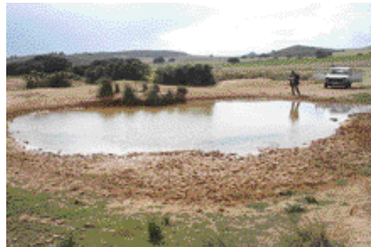
Balsa para retención de agua excavada. Balsa del Almendro (BAImen).
