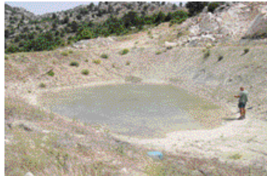
Balsa excavada para riego naturalizada. Hoya Lóbraga (BHL-02).
