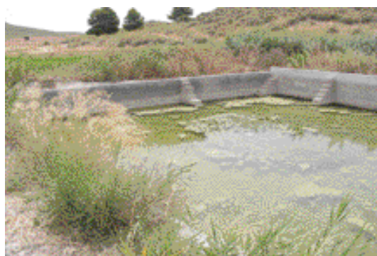
Balsa para riego de hormigón. Agua Amarga (BAM-01).
